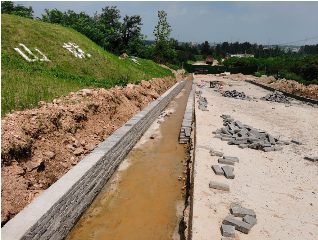
照片 1-1 矿山在建排水沟
