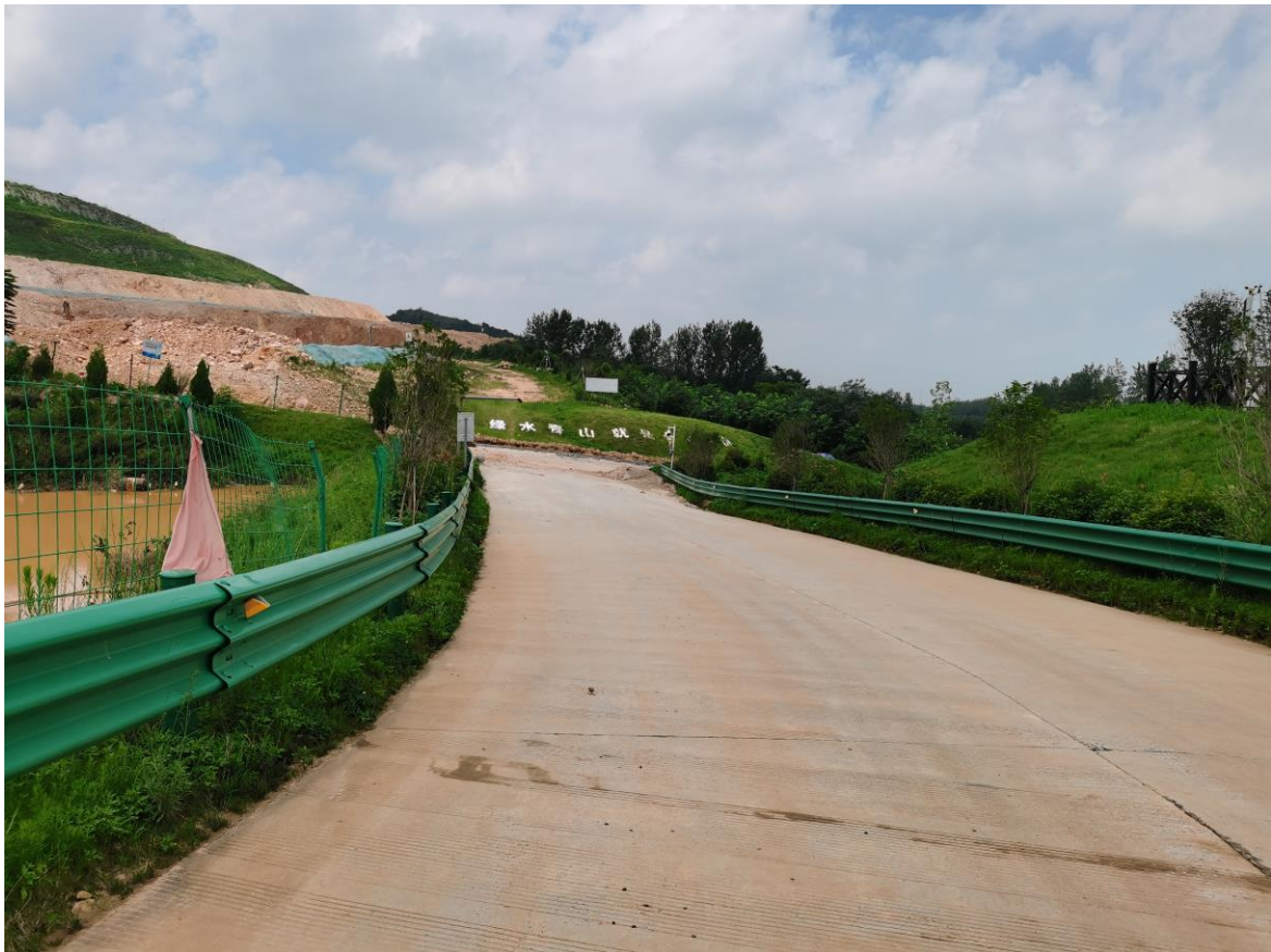
照片 3-5 矿山运输道路现状
