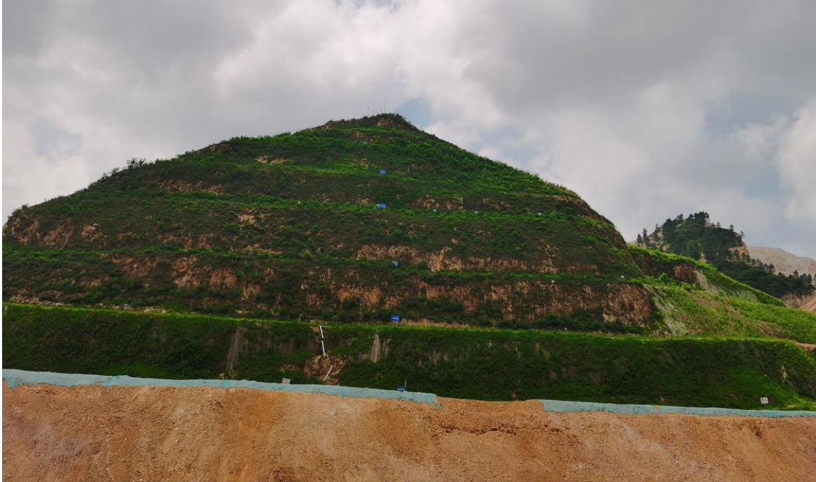
照片 3-1 矿山北向边坡现状
