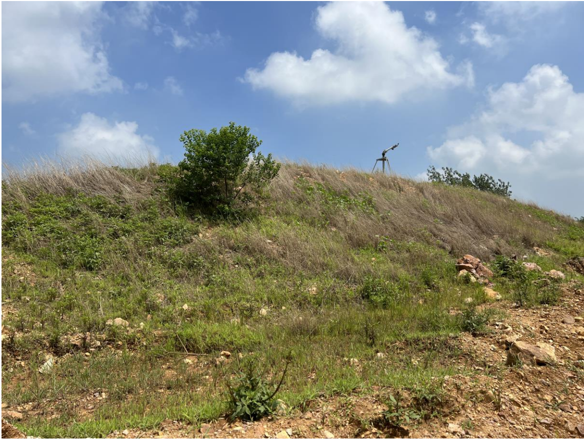
照片 3-3 矿山现有临时表土堆场现状
