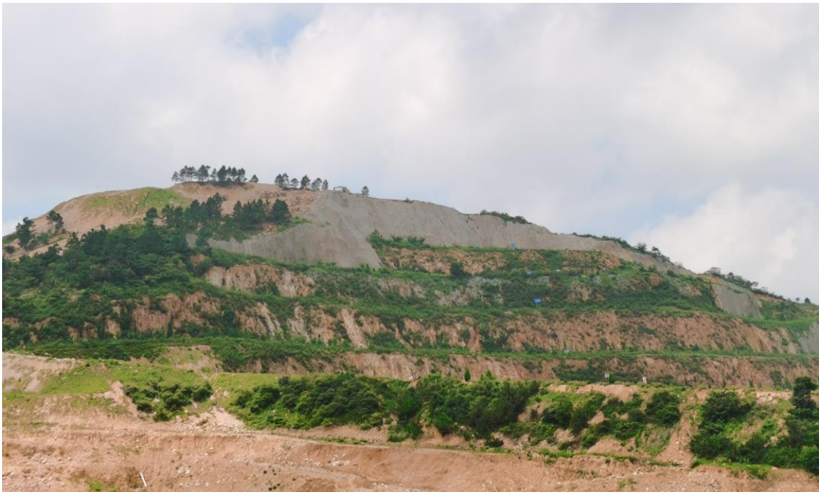
照片 3-2 矿山北东向边坡现状
